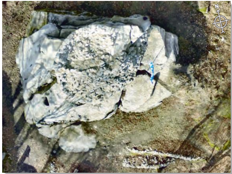
Abb. 38: Luftaufnahme des sanierten Turmsockels
