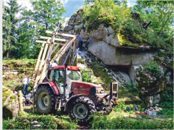
Abb. 225: Aufrichten der Holzkonstruktion
