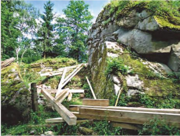
Abb. 224: Vorbereitete Stützbalken
