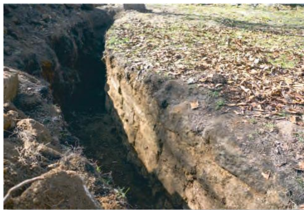
Abb. 51: Freigelegte Grundmauer im Wegbereich 1
