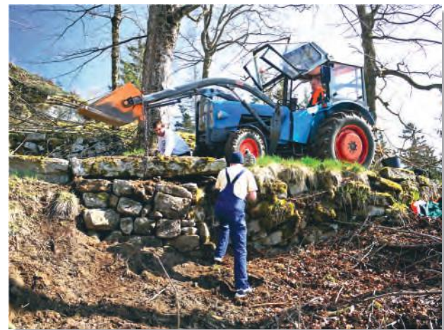
Abb. 223: Instandsetzen des Zufahrtweges
