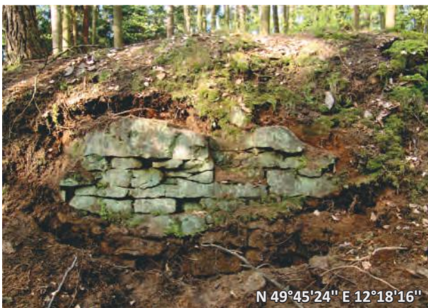
Abb. 17: Vermeintliche Mauer am „Haustein“
